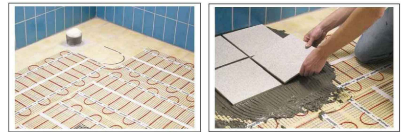
Монтаж нагревательного мата теплого пола
