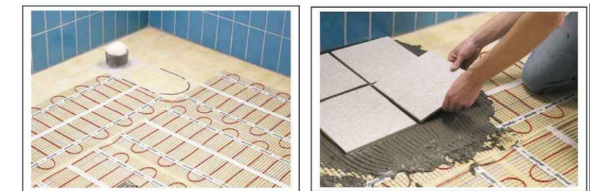
Монтаж нагревательного мата теплого пола
