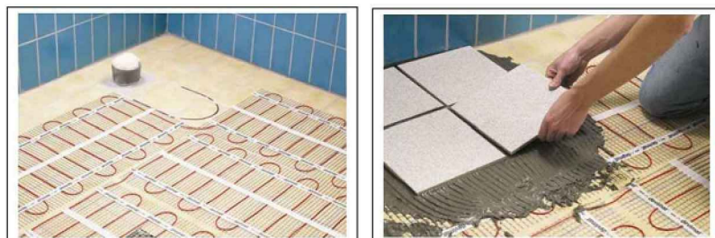
Монтаж нагревательного мата devimat DTIF
